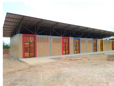
Construction d'une école primaire
