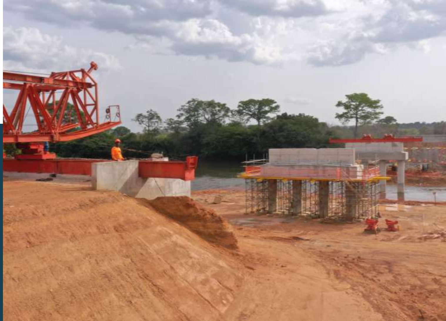
Construction d'un pont
